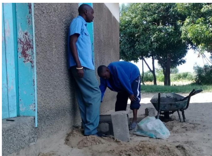
Patrick Siyauya, voorzitter van Zambridge in Senanga, ziet toe op reparatie werkzaamheden aan het HBC-gebouw.
