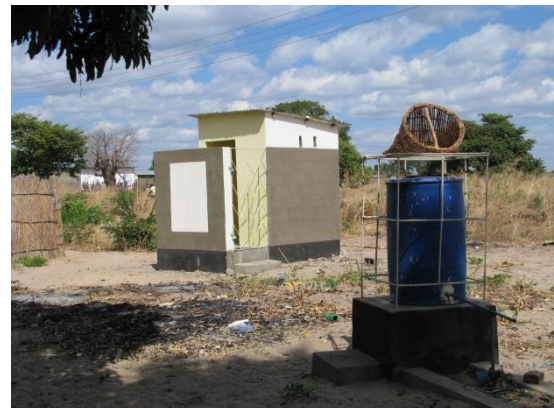
Het al eerder gebouwde VIP toilet bij HBC
